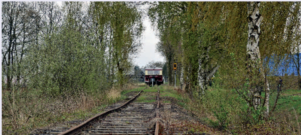
Die Sonderfahrt des „Wismarer“ T 1 der Museums-Eisenbahn Minden endete am 27.04.13 im Industriegebiet von Bohmte-Bruchheide, da die anschließende Strecke nach Schwegermoor zu diesem Zeitpunkt bereits seit einigen Jahren gesperrt war. Nun könnte der bislang – entgegen der grundsätzlichen Betriebspflicht – „kalt stillgelegte“ Abschnitt allerdings auch förmlich stillgelegt werden. Das Verfahren nach § 11 AEG würde einem möglichen neuen Betreiber Chancen zur Übernahme eröffnen. Foto: Stefan Högemann
