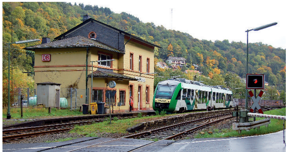
Ein offensichtlicher Missstand aufgrund fehlender Regulierung im Bahnsektor ist die gleichzeitige Nutzung des roten DB-„Kekses“ sowohl durch die Verkehrs- als auch durch die Infrastrukturunternehmen des DB-Konzerns. Die gemeinsame Verwendung führt nämlich zu der bizarren Situation, dass an Bahnhöfen und Haltepunkten, an denen nach Wettbewerbsverfahren gar keine Züge der Deutschen Bahn AG mehr halten, nach wie vor der „Keks“ angebracht ist, wie z. B. hier in Laurenburg an der Lahntalbahn. Gleichzeitig fehlen jedoch oftmals ähnlich großformatige Hinweise auf die hier nun tatsächlich verkehrenden Wettbewerbsbahnen. Abhilfe könnte eine neutrale Sektormarke schaffen, die alle Akteure des Schienenverkehrs gleichermaßen repräsentiert.
